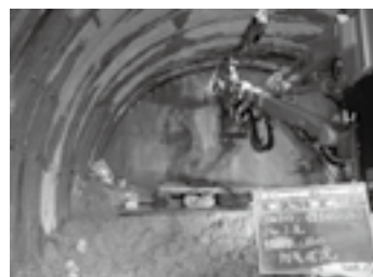
鏡ボルト施工状況▶P.5
